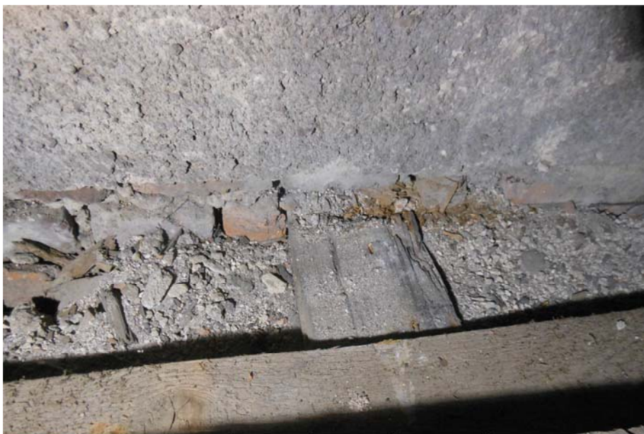
5. HNILOBA STROPNÍHO TRÁMU ZPŮSOBENÁ DŘEVOMORKOU DOMÁCI-Serpula lacrymans (Wulfen) P.Karst.
